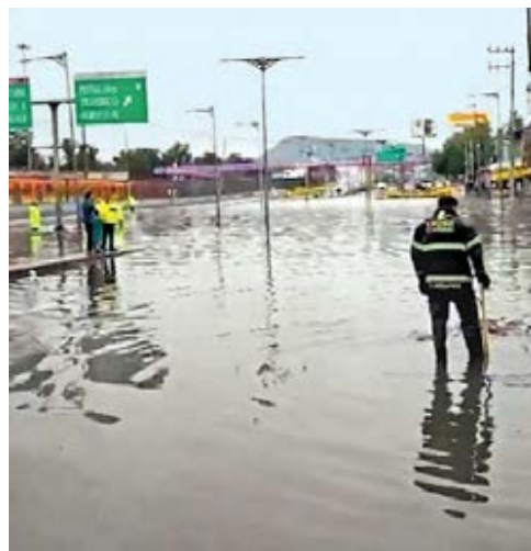
Inundación en la calzada Ignacio Zaragoza. ESPECIAL
