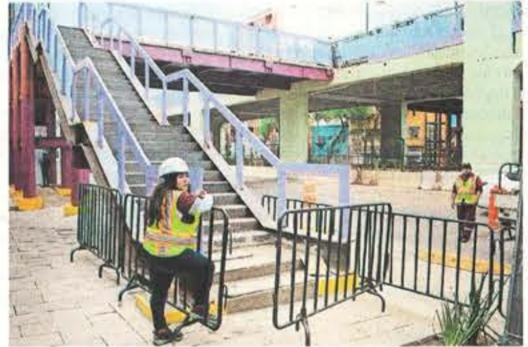
Uno de los pendientes de la obra, que costó más de 2 mil millones de pesos, es la conclusión de puentes peatonales.
